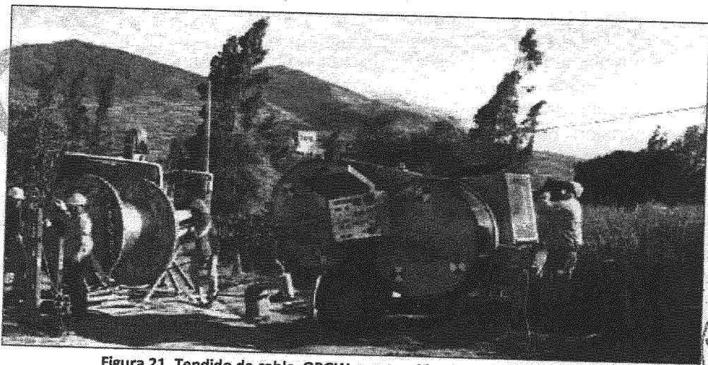
Figura 21. Tendido de cable OPGW con tensión controlada
