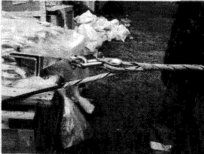
Retención para vano 300 a 600m con abrazadera de 80mm apoyada en perfil horizontal en torres
