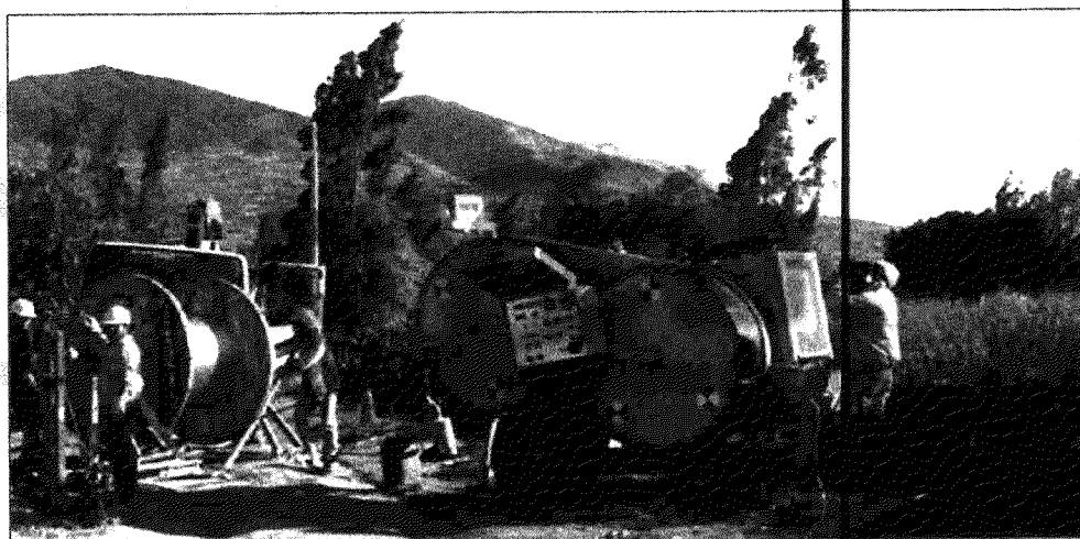
Figura 21. Tendido de cable OPGW con tensión controlada
