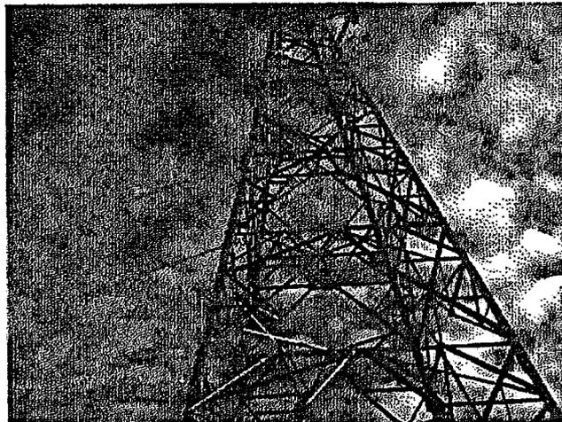
Vista de perfiles horizontales de 2½" x 2½" con ángulo hacia el exterior, donde podria ir las abrazaderas de 80mm con los soportes de retención
