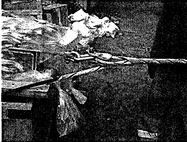
Retención para vano 300 a 600m con abrazadera de 80mm apoyada en perfil horizontal en torres
