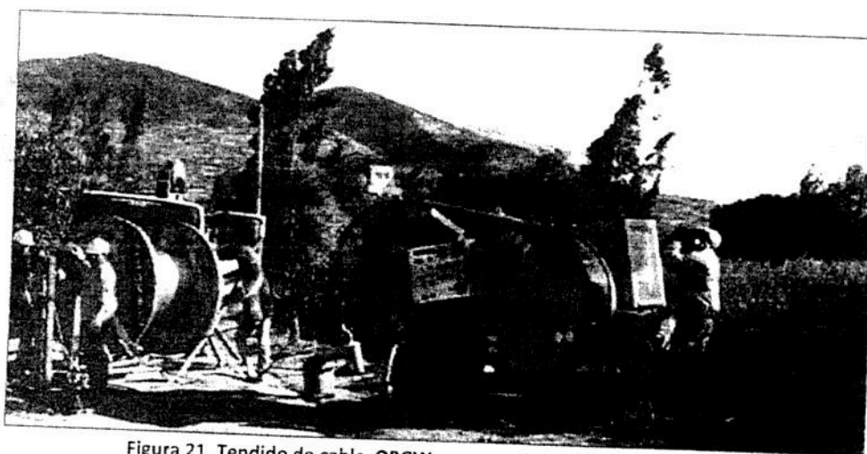
Figura 21. Tendido de cable OPGW con tensión controlada
