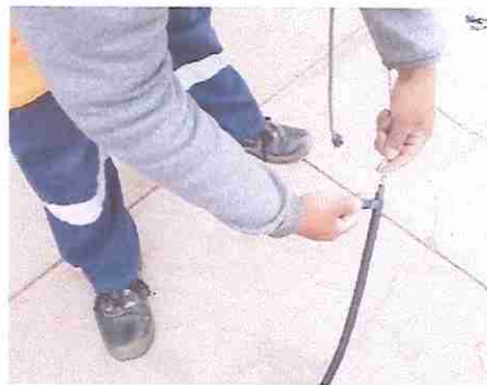
Alistamiento de cable - Protección
