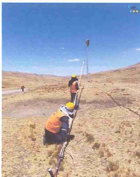
Proceso de flechado de cable de Fibra Óptica
