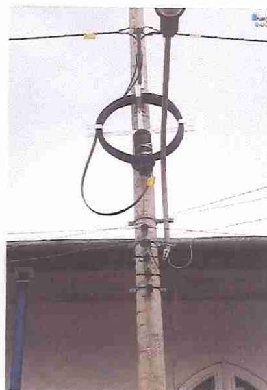
Acondicionamiento de cierre de empalme en estructura
