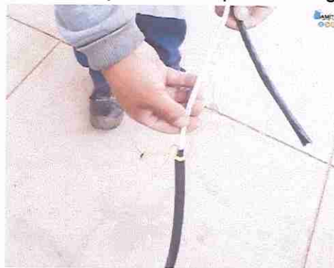
Alistamiento de cable – Retiro de protección del cable
