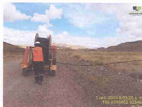
Proceso de tendido de cable de Fibra Óptica
