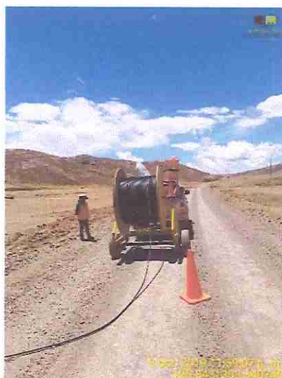
Proceso de tendido de cable de Fibra Óptica
