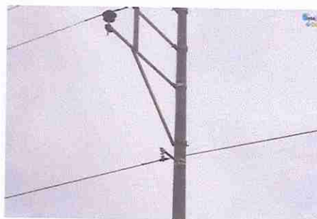
Herraje de suspensión instalado
