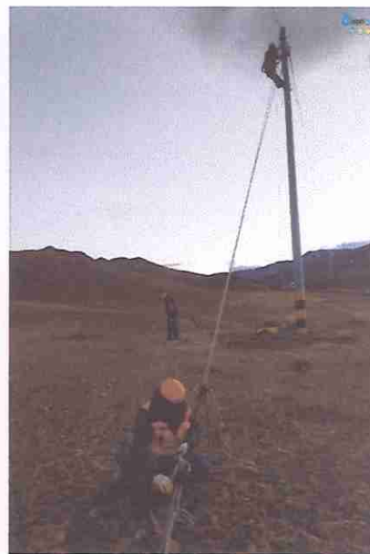
Proceso de flechado de cable de Fibra Óptica
