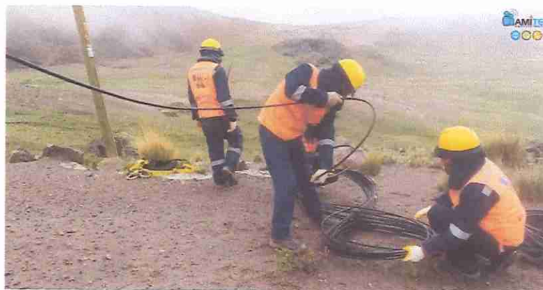
Extracción de cable en forma de 8
