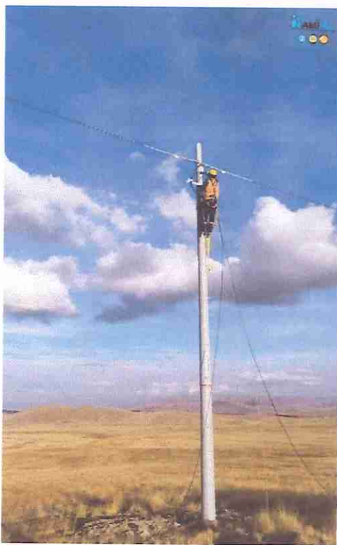
Instalación de crucetas
