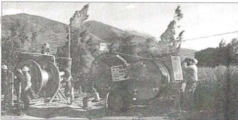
Figura 21. Tendido de cable OPGW con tensión controlada
