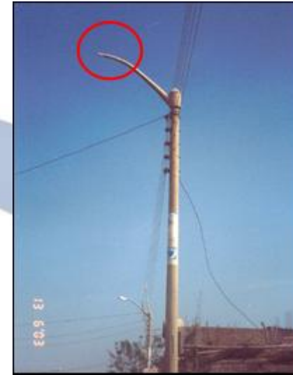
Falta de Lámpara (UAP)
